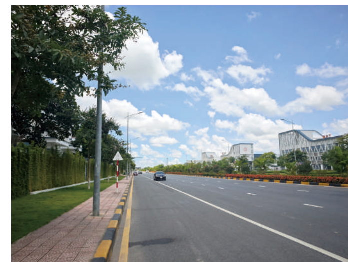
深越路—深越园区主干道 2018年完工
