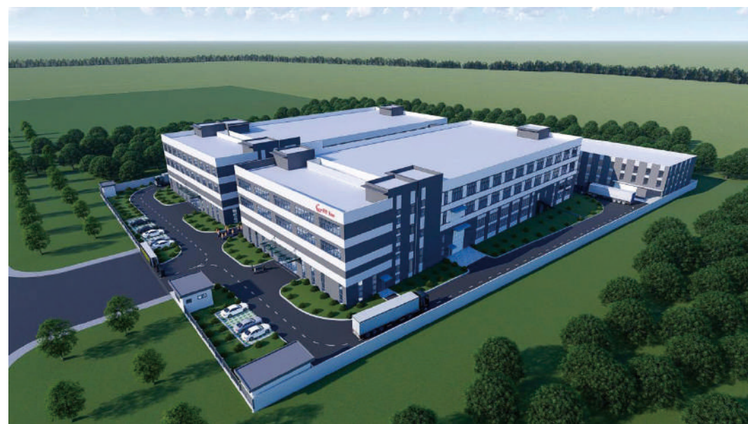
中科冠腾越南科技有限公司新建厂房项目（在建）
